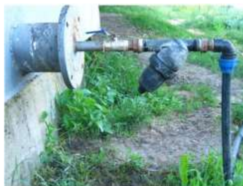
Fig. 21 Conducta principală a instalației de udare localizată
