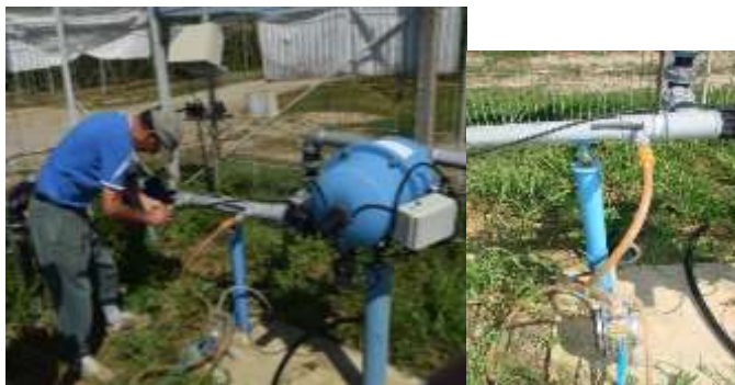
Fig. 17 Bransarea dispozitivului de injectie solutie primara la conducta principala a instalatiei de udare localizata
