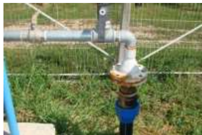
Fig. 13 Bransamentul instalatiei de fertirigatie
