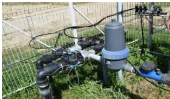
Fig. 16 Contor de apa, filtru cu sita, retea de distributie, electrovane
